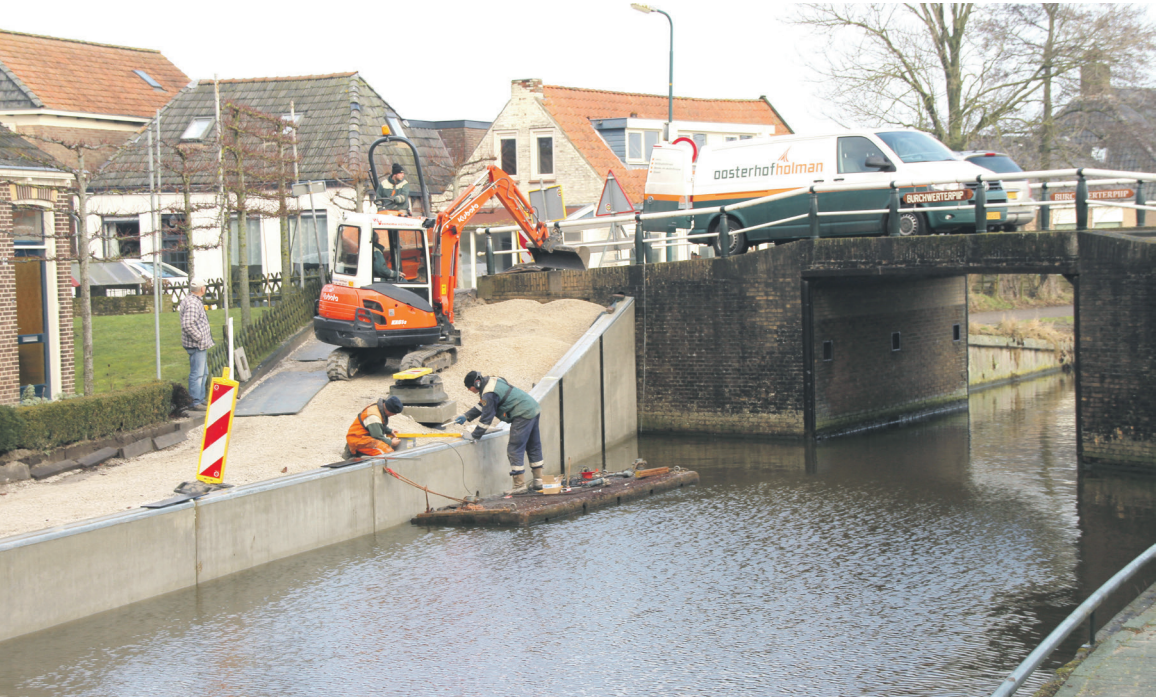
Yn Burchwert wurdt hurd wurke oan de renovaasje fan de kademuerre fan it Trekpaad. It wurk is yn novimber 2016 útein setten en moat neffens de ôfspraak foar 1 maart fan dit jier klear wêze. Oant salang kin der net fan it Trekpaad gebrûk makke wurde.
